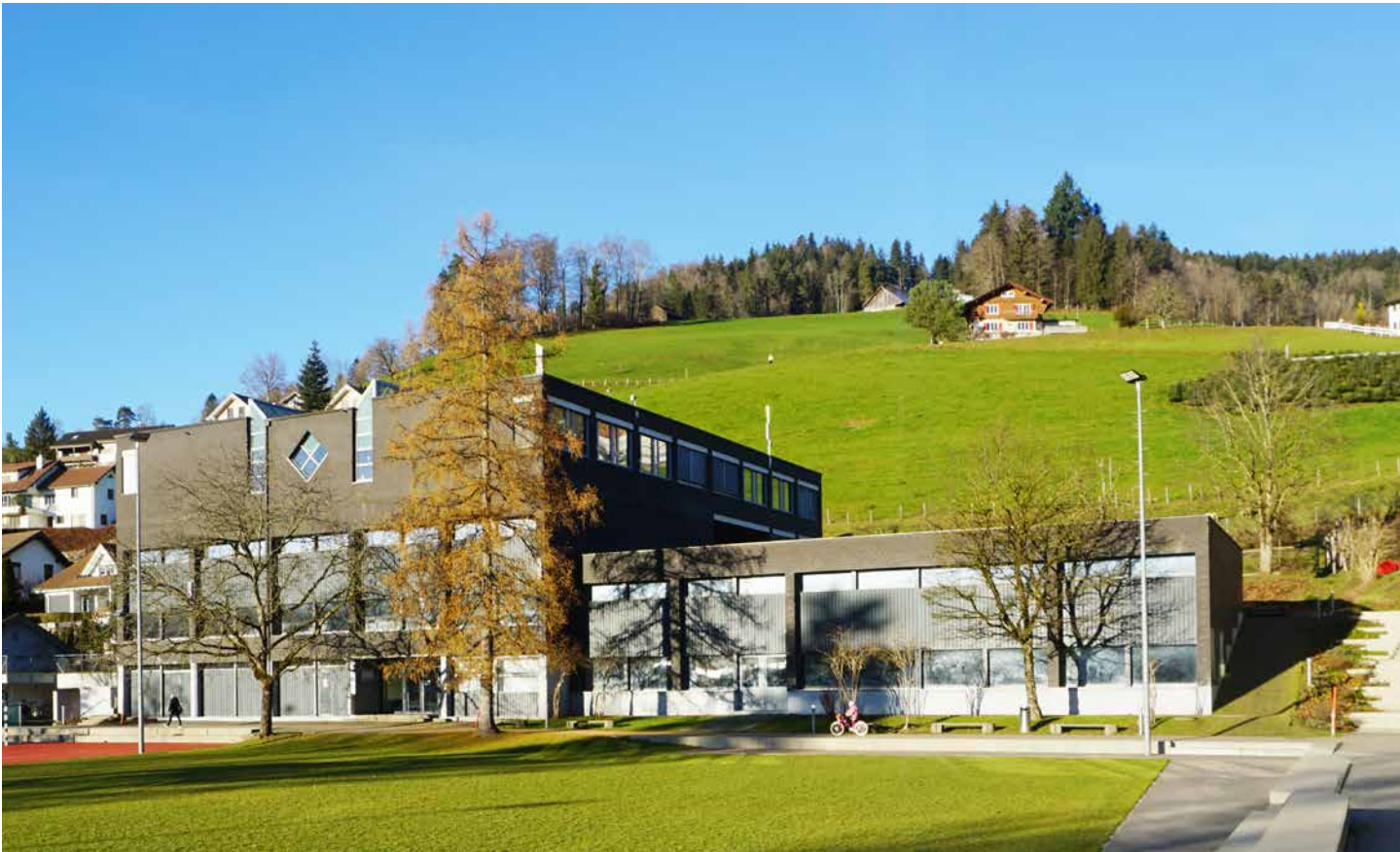
Das Schulhaus Acher West erfüllt die heutigen Anforderungen und Bedürfnisse nicht mehr.
